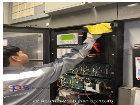
เจ้าหน้าที่ตรวจสอบเช็คระบบป้องกันอัคคีภัยและแจ้งเตือนอัคคีภัย
