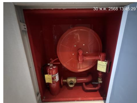
ตู้เก็บสายฉีดน้ำดับเพลิง FHC
