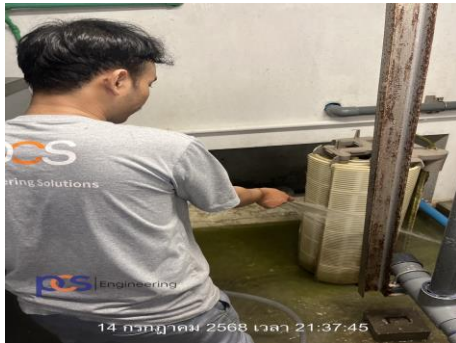
เจ้าหน้าที่ตรวจสอบระบบปั๊มและระบบกรองสวะน้ำ
