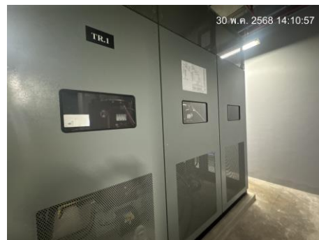
ตู้ MDB และหม้อแปลงไฟฟ้าโครงการ
