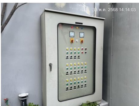
ตู้ควบคุมระบบบำบัดน้ำเสียโครงการ
